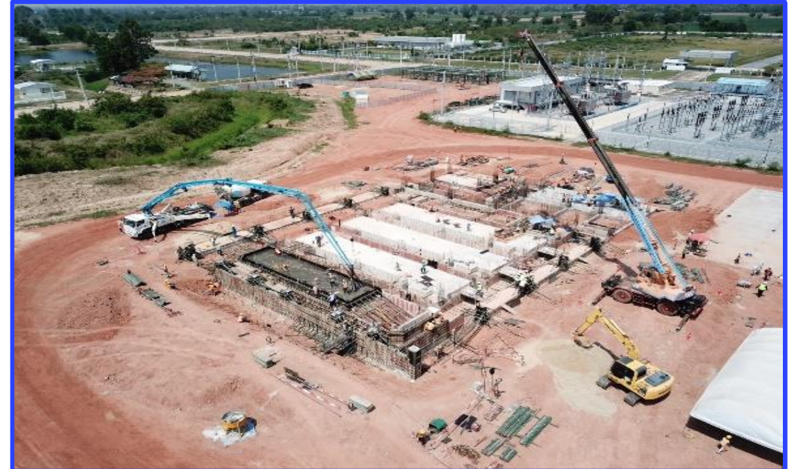
ภาพการก่อสร้างโรงไฟฟ้า
