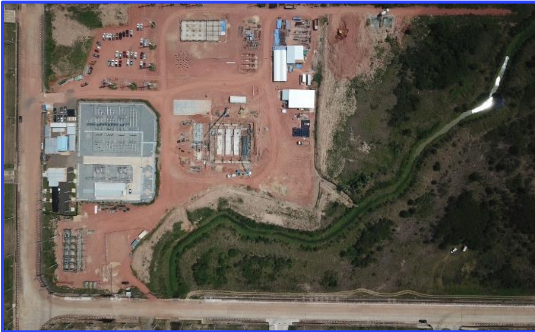
ภาพการก่อสร้างโรงไฟฟ้า
